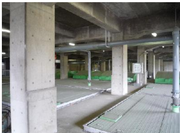
写真 1 下水処理センター
